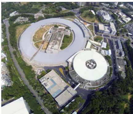
國家同步輻射研究中心新建試車中的台灣光子源(大環)及原有運轉中的台灣光源(小環)兩座同步加速器空照圖（圖片來源：同步輻射中心提供）
