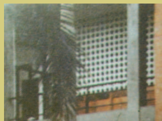
● 未修建前的圖書館陽台
